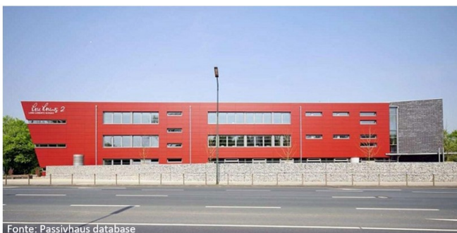
Edificio 1: Scuola a Düsseldorf (Germania)
